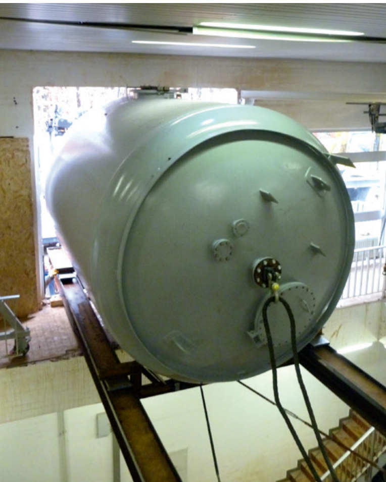
Abb. 6 – Seitlicher Ausbau der alten Filterkessel, Einbau der neuen Kessel
